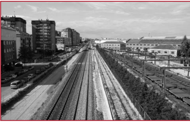
Figura 6. Valladolid: pasillo ferroviario entre el barrio de La Rubia y el Polígono de Argales –Redalsa–. © Foto: BCC
